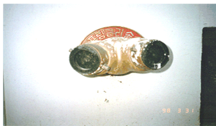
[그림 1-106] 스프링클러 송수관 및 헤드의 설치
